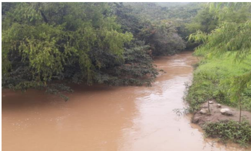
FIGURA N°02: TRAMO CRITICO DE RIO SHOCOL, DONDE SE OBSERVA LOS BORDOS CON POCA ALTURA PERMITIENDOLE DESBORDARSE Y CAUSAR INUNDACION.
